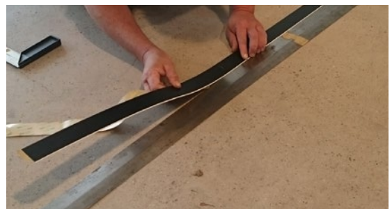
Efter noggrann inmätning så drar man enkelt av skyddspappret från stråkets baksida.
